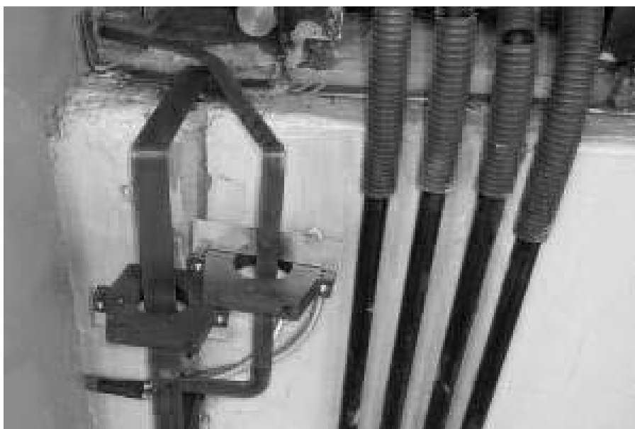
Рис.1. Пример установки датчиков (высокочастотных трансформаторов тока) для регистрации частичных разрядов в электрооборудовании
