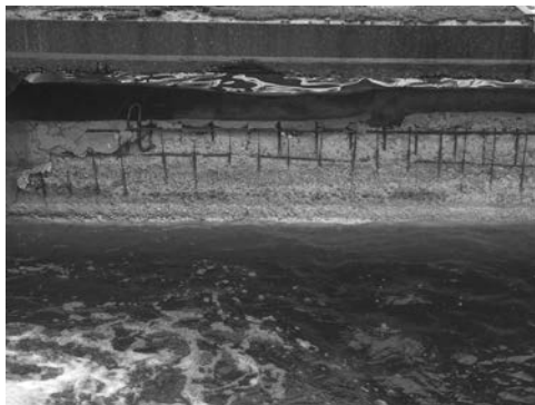
Рис.2. Состояние железобетонных конструкций аэратора-усреднителя после длительного воздействия щелочных и кислых сточных вод
